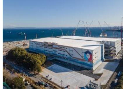
YOKOHAMA SACHIURA DAĞITIM MERKEZİ 1
